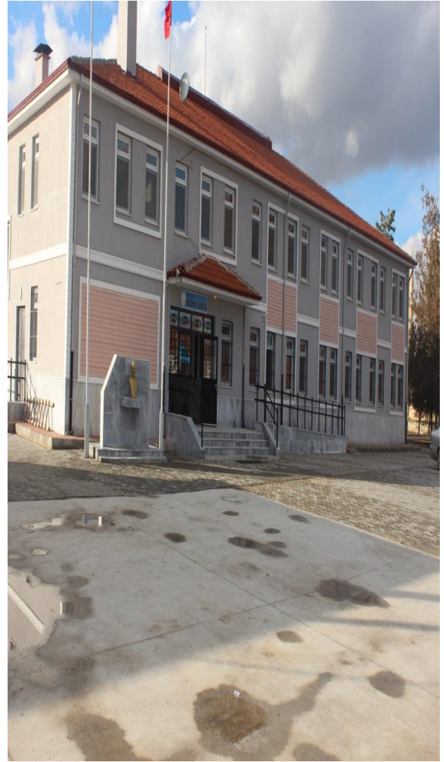
Merkez Sülümenli İlkokulu 12 Derslik Yapımı
